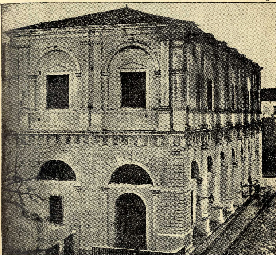
Εἰκ. 15. ᾽Αποψὶς τῆς Λότζας ἐκ τῆς ΒΔ γωνίας αὐτῆς, πρὸ τῆς κατεδαφίσεώς της.
